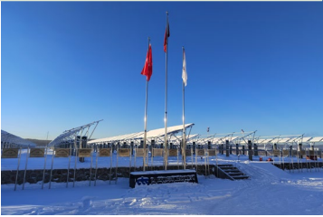
国检集团漠河极寒测试产业园
